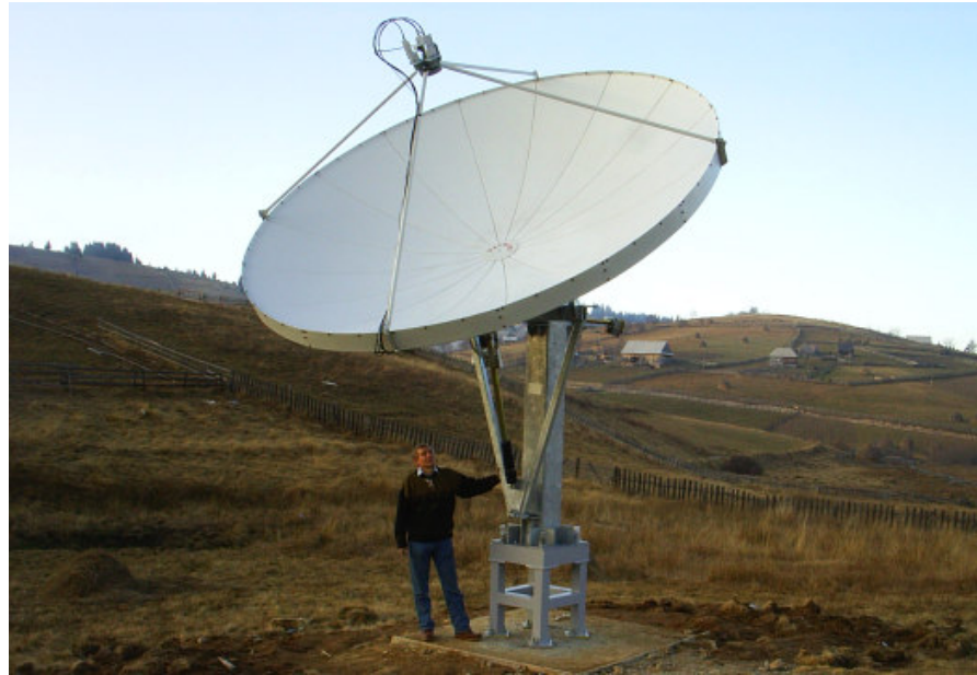
Stație de căutare automată a sateliților. Rază de acțiune, din România, la altitudini geostaționare: longitudini cuprinse între estul oceanului Atlantic și India/China. Instalată de BITNET la 1.250 m altitudine - octombrie 2006.
